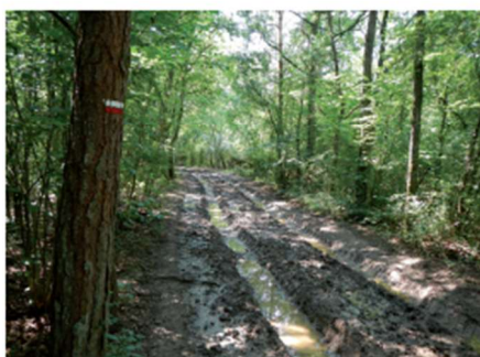
Ornière liée à la sur-fréquentation du chemin pouvant nécessiter une remise en état
